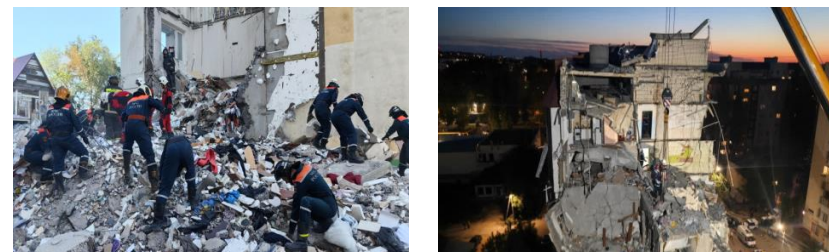
Рис. 1.28. Ликвидация последствий взрыва газовой смеси в многоквартирном жилом доме в Саратовской области
