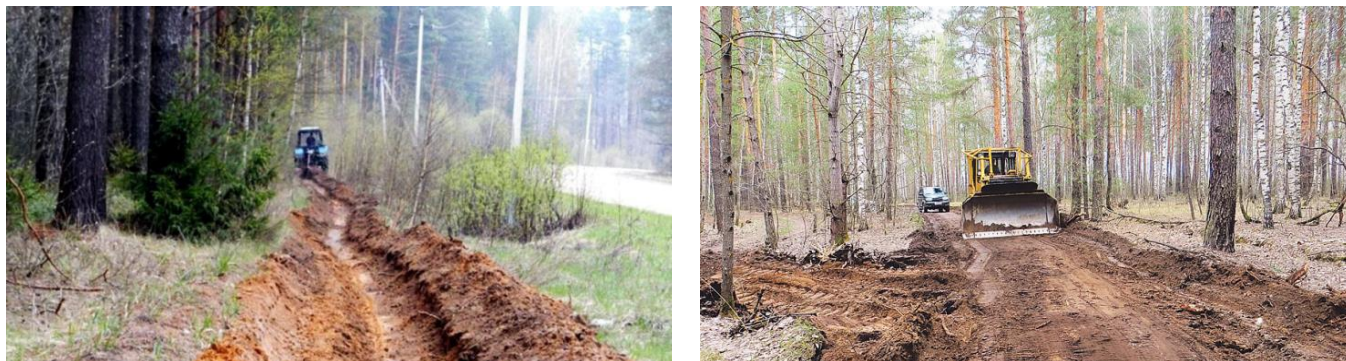
Рис. 2.15. Устройство противопожарных минерализованных полос и создание лесных дорог
