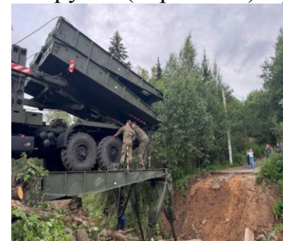
Рис. 2.2. Развертывание временного моста через реку
